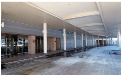
※玄関前のバス乗降スペースでは、貸切バス10台ほどが一斉に配車可能です。 (屋根がある為、雨に濡れる心配もありません)
